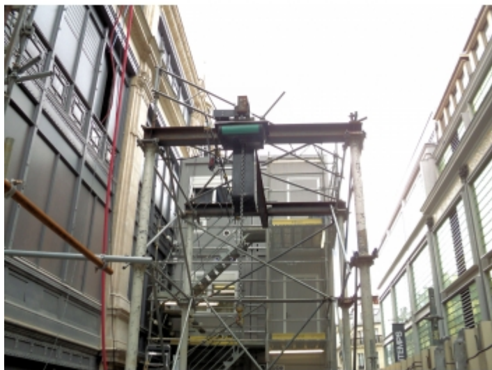
Installation sur fer
