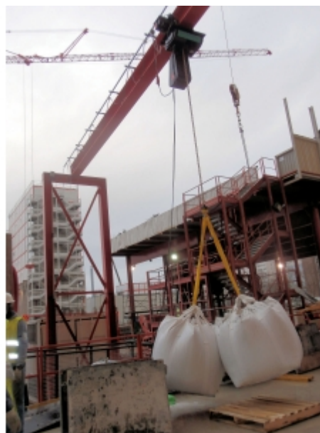
Installation sur fer
