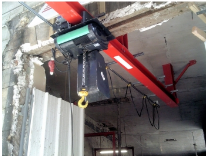
Installation sur fer
