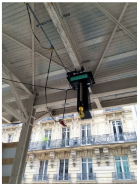
Installation sur fer
