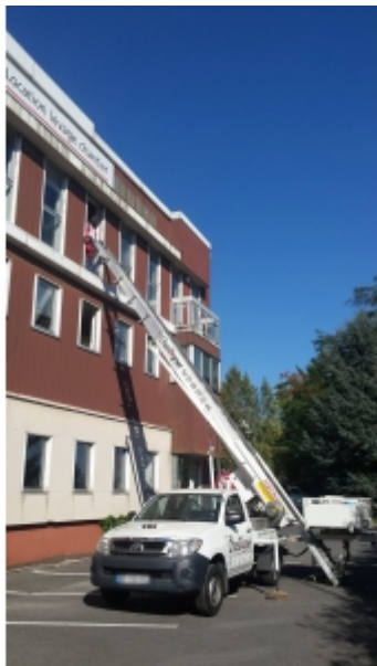
Installation depuis la fenêtre d'un bâtiment
