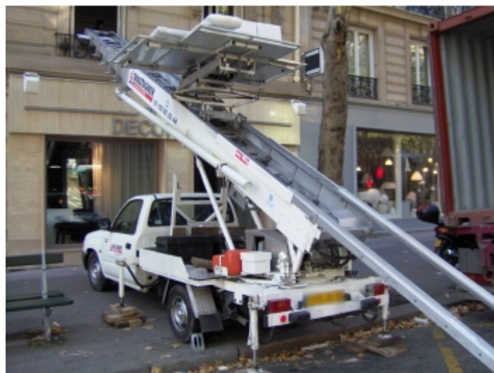
Levage de matériaux
