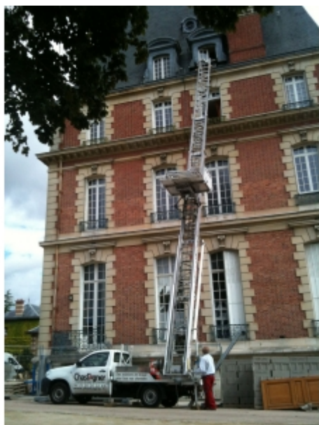
évacuation de meubles
