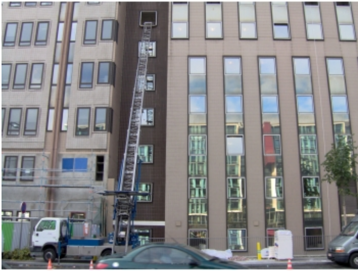
évacuation de meubles
