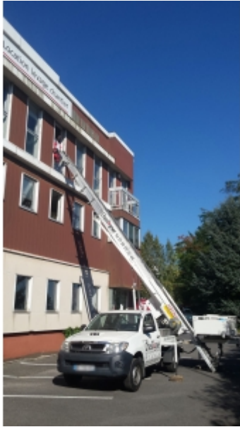
Installation depuis la fenêtre d'un bâtiment
