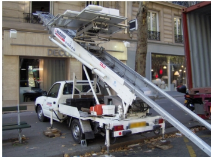
Levage de matériaux
