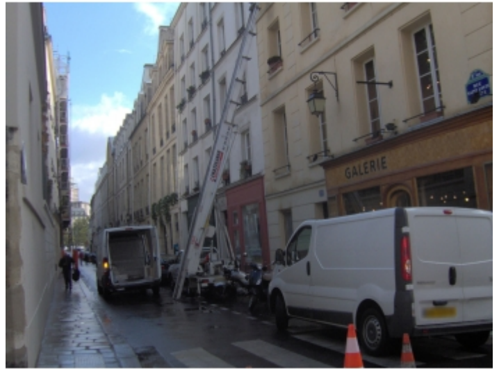
évacuation de meubles
