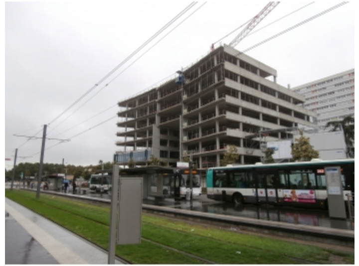
Installation sur un bâtiment
