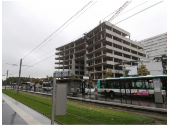
Installation sur un bâtiment
