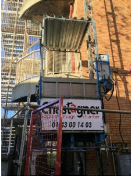
Installation sur un bâtiment
