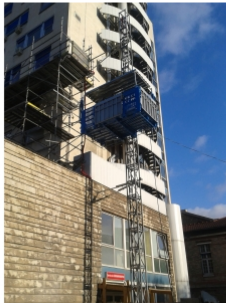
Installation depuis la façade d'un bâtiment
