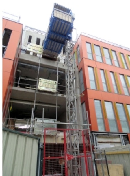
Installation sur échafaudage
