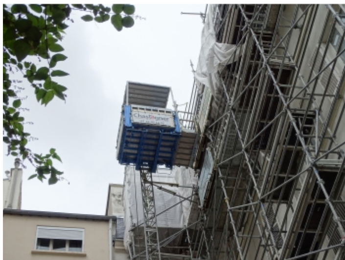
Installation sur échafaudage
