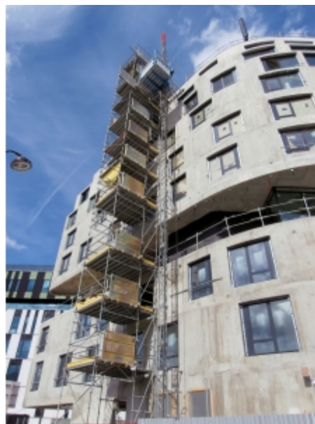
Installation sur échafaudage
