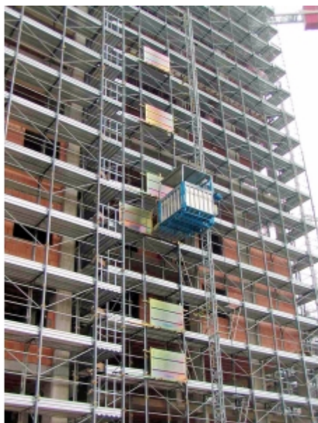
Installation sur échafaudage
