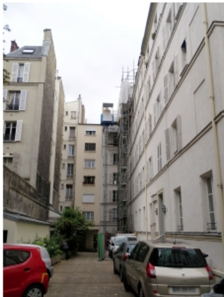
Installation sur échafaudage
