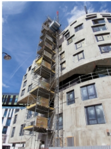
Installation sur échafaudage
