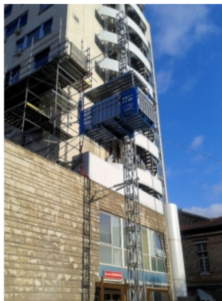
Installation sur échafaudage
