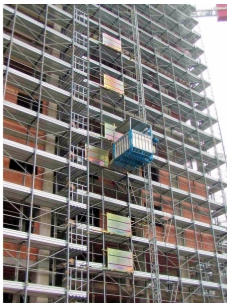
Installation sur échafaudage
