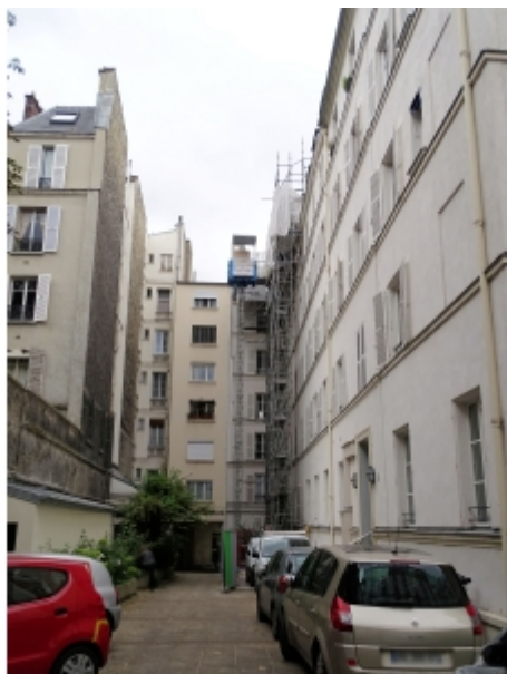
Installation sur échafaudage
