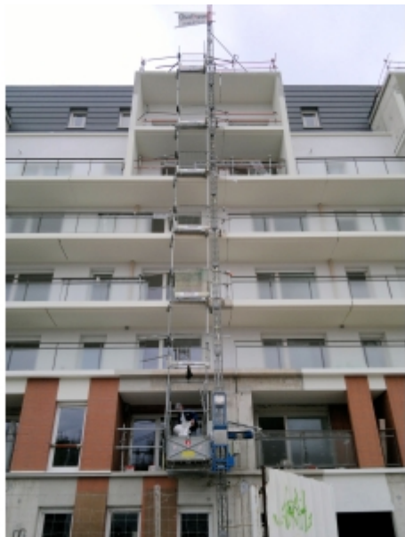
Installation sur échafaudage
