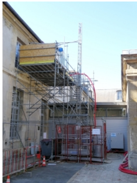
Installation sur façade
