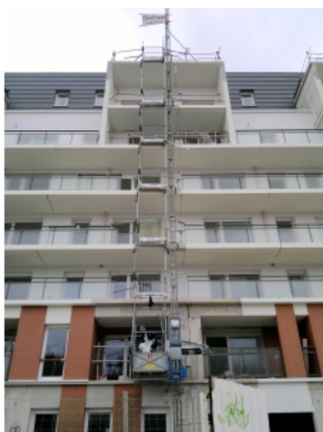
Installation sur façade
