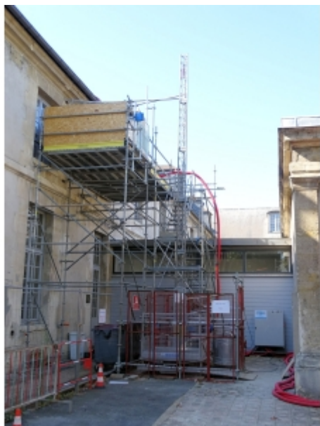
Installation sur échafaudage
