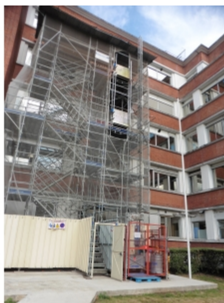
Installation sur échafaudage
