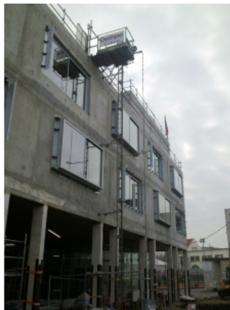
Installation sur façade
