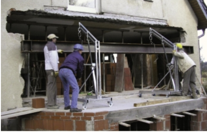
Mise en place d'une poutre sur chantier avec 2 lève-poutres
