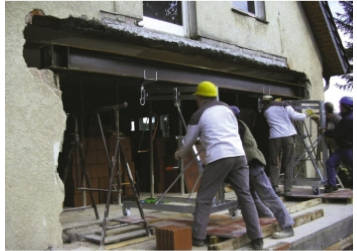
Mise en place d'une poutre sur chantier avec 2 lève-poutres
