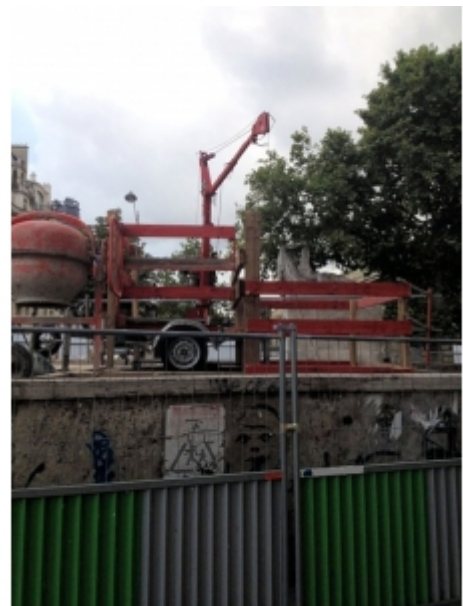
Travaux de réseaux
