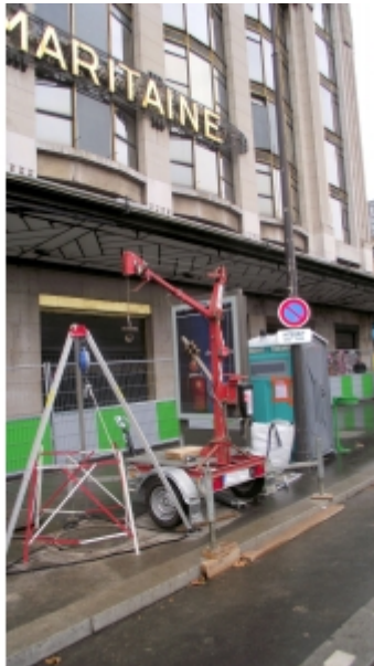
Travaux de réseaux
