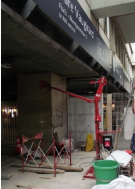
Travaux de réseaux
