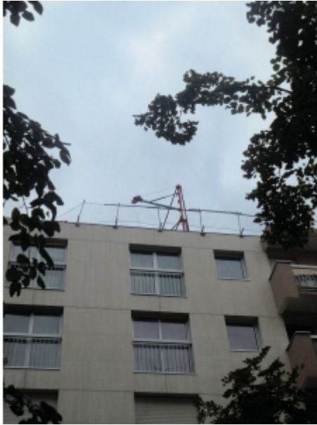
Installation en terrasse
