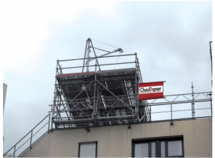
Installation sur une plateforme d'échafaudage
