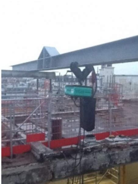
Installation sur fer avec un palan électrique
