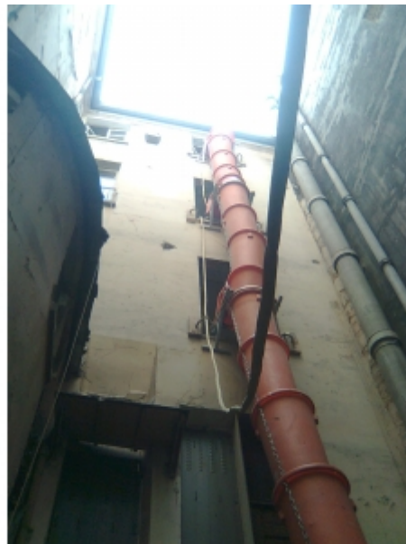
Installation sur chantier
