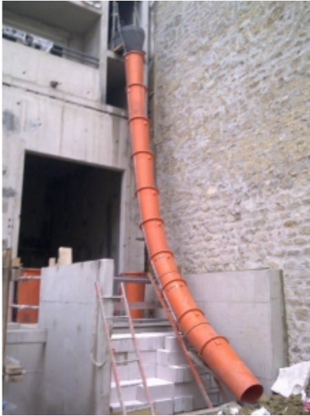
Installation sur chantier
