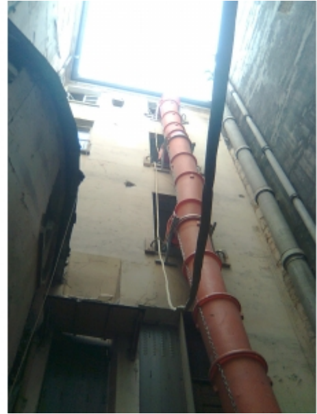
Installation sur chantier
