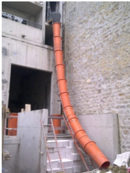
Installation sur chantier
