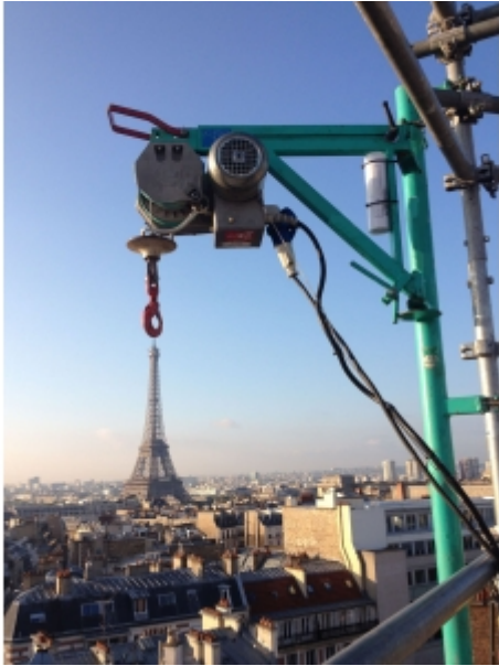
Treuil potence monté sur un étai d'échafaudage
