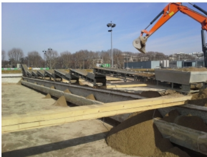
évacuation de gravât
