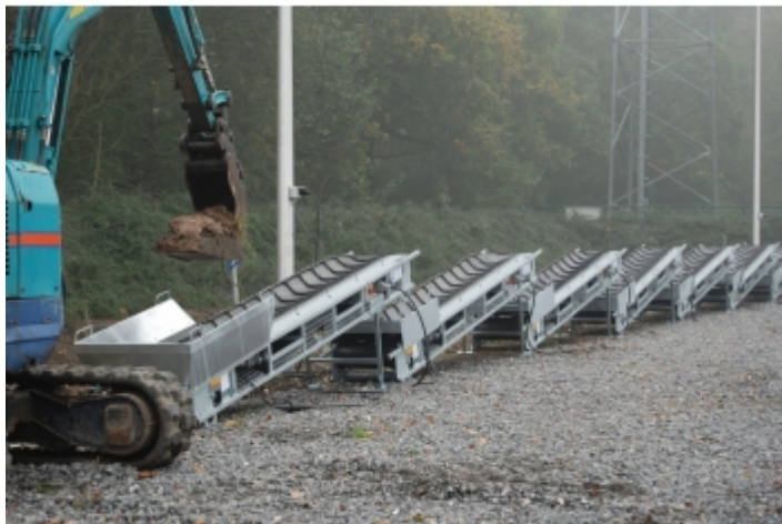
évacuation de gravât
