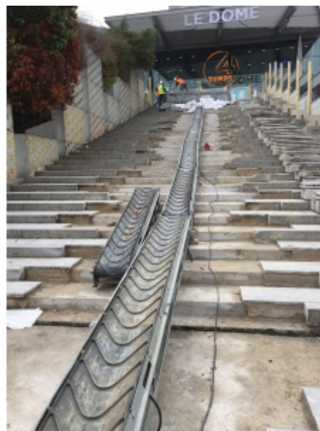
évacuation de gravât
