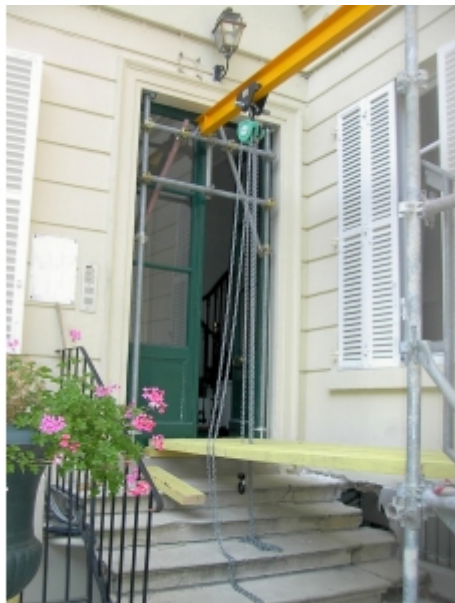
Installation sur fer avec un palan manuel
