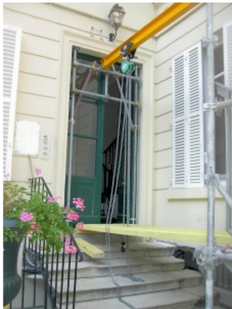
Installation sur fer avec un palan manuel
