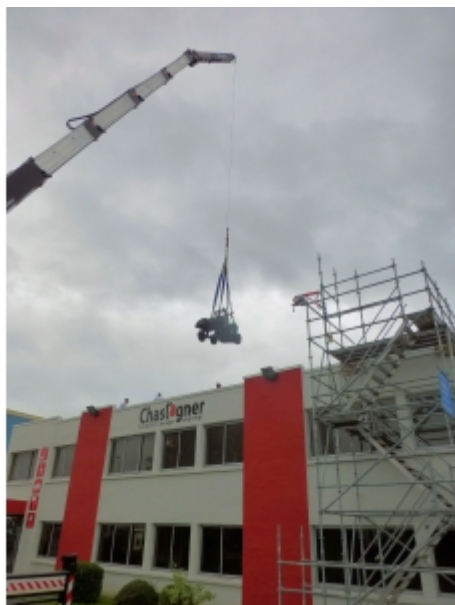
Levage d'un chariot électrique avec un camion-grue
