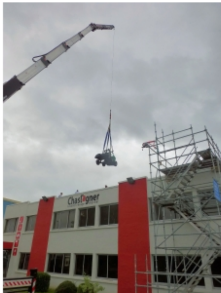
Levage d'un chariot électrique avec un camion-grue
