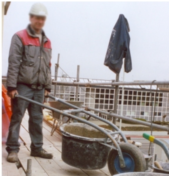
Manutention d'un seau sur chantier
