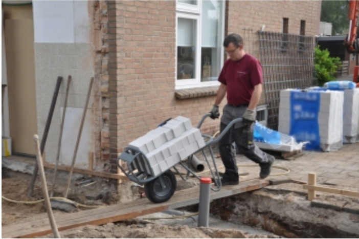
Manutention de charges sur chantier - version brouette
