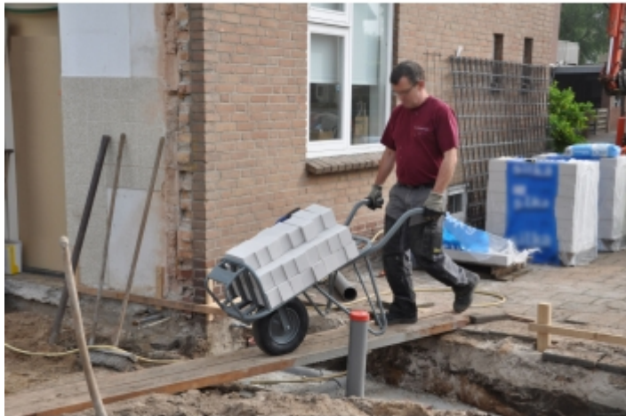
Manutention de charges sur chantier - version brouette
