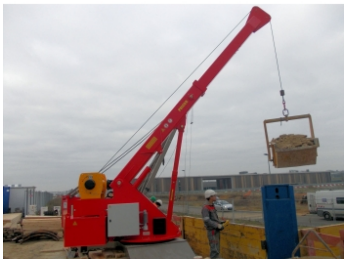
Travaux de réseaux
