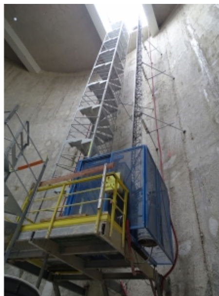
Installation dans une trémie
