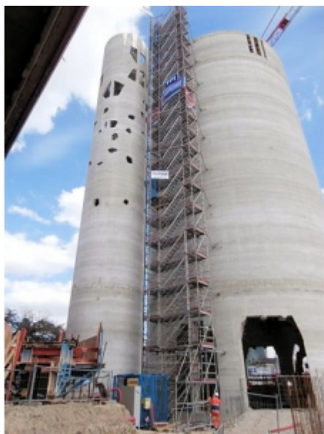
Installation sur échafaudage
