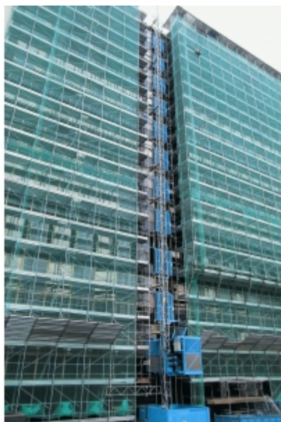
Installation sur échafaudage
