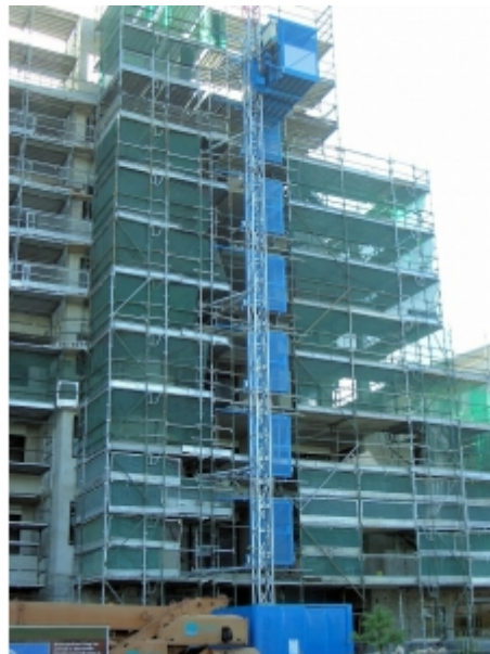
Installation sur échafaudage
