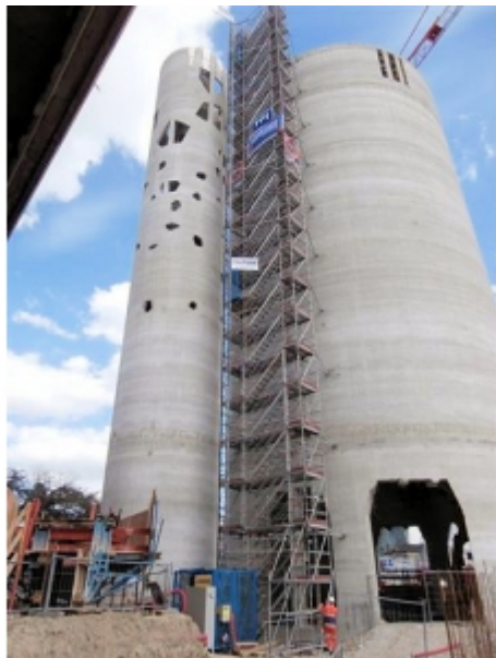
Installation sur échafaudage
