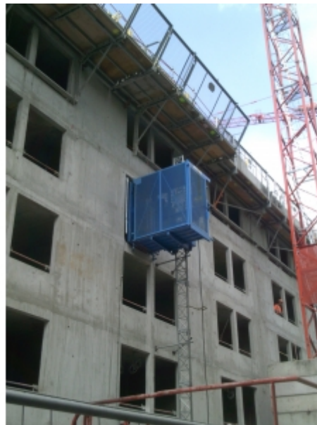
Installation depuis la façade d'un immeuble
