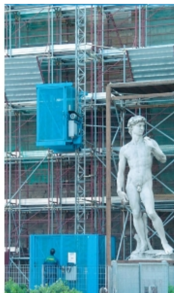
Installation sur échafaudage
